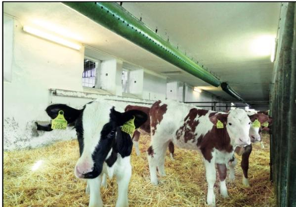
Abb. 1: Zugluftfreies Frischluftsystem für Kälber
