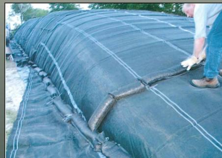
Schritt 4: Erstellung der Querbarrieren mittels Kiessäcke.
