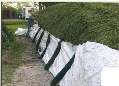
Schritt 1: Umschlagen der Seitenfolie und Befestigung durch Kiessäcke
