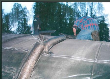
Schritt 6: Befestigung der Kiessäcke am Siloschutzgitter.
