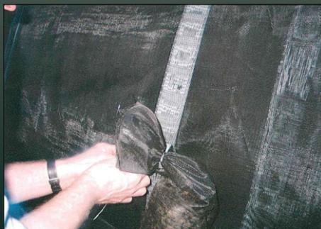
Schritt 5: Kiessäcke am Siloschutzgitter befestigen
