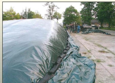
Schritt 2: Befestigung der ausgebreiteten Silofolie mit Kiessäcken
