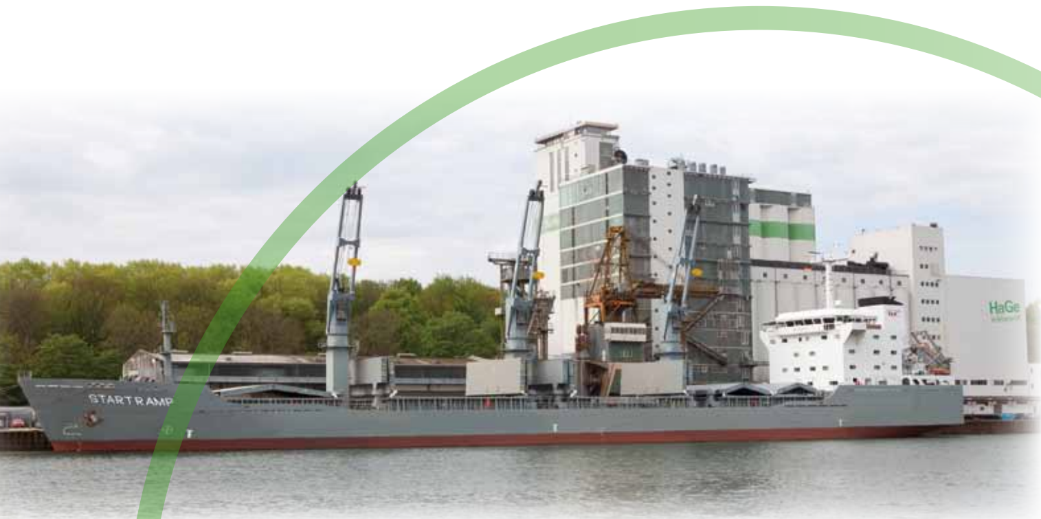
RÖV Raiffeisen Ölsaatenverarbeitungs GmbH, plant Kiel
