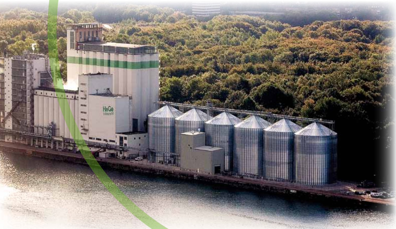
SKN Silo Kiel-Nordhafen, Lagerkapazität für Getreide ca. 110.000 to
